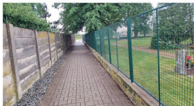
... a s novým nátěrem
