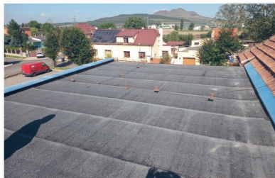
Nová střecha na přísálí sokolovny
