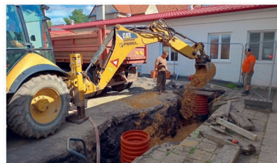
Budování kanalizační přípojky do MŠ
