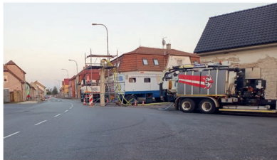
Rekonstrukce kanalizace v ulici Dlouhá
